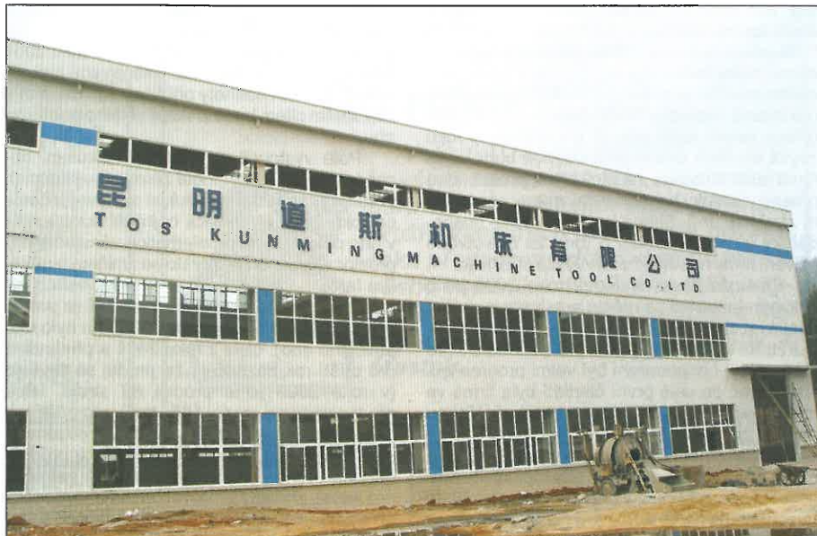
Rozestavěná budova továrny nově vznikajícího společného podniku v Číně.
