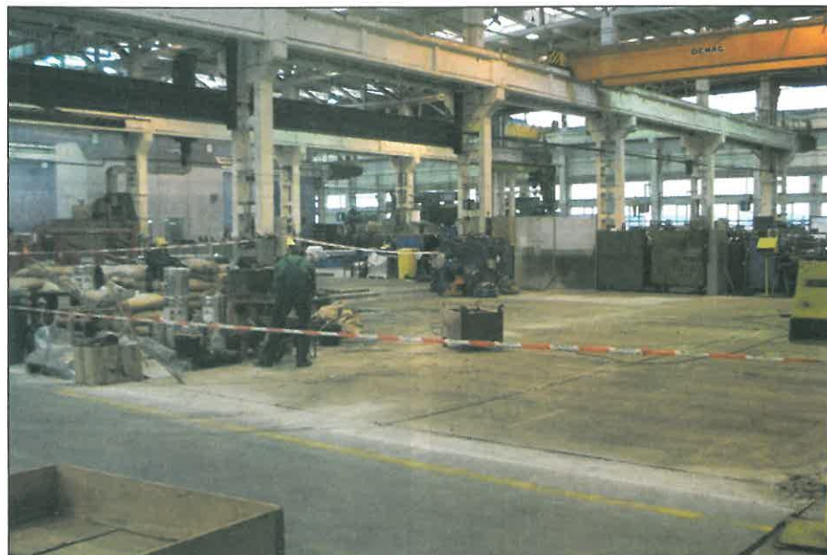
Montážní plochy, kde se dříve montovaly WHQ 105CNC, jsou nyní vyklizené a podlaha dostává nový, fešácký povrch. Fotografie v úterý 29. ledna 2008 pořídil a textem doplnil TOM.
